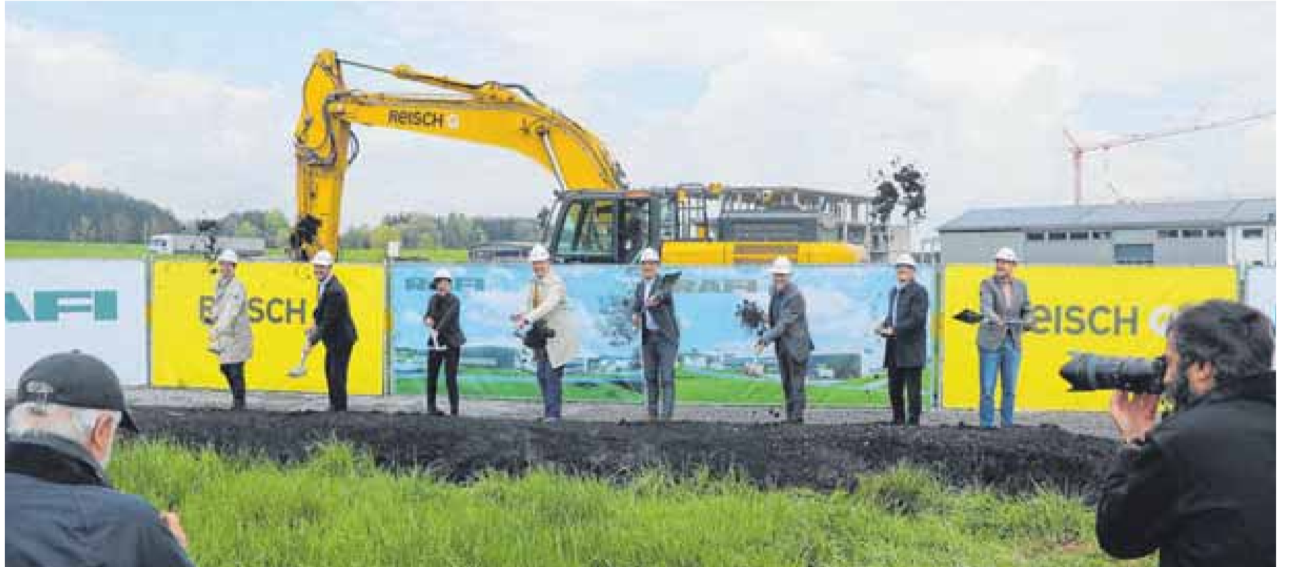
Auf den Spaten, fertig, los: Beim Spatenstich im Gewerbegebiet Wasserstall war die Freude über den Baustart spürbar. FOTO: WOLFGANG HEYER
