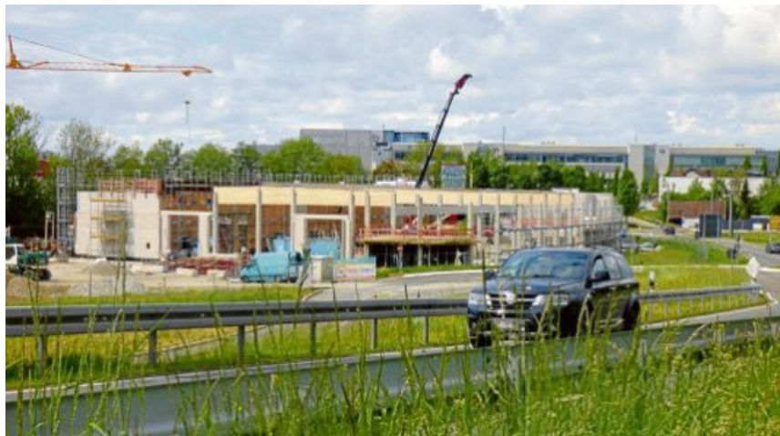
Am Ortsausgang von Markdorf Richtung Friedrichshafen entsteht derzeit die neue Straßenmeisterei des Landkreises. Im Herbst 2027 soll sie fertiggestellt sein. FOTO: HELMAR GRUPP
